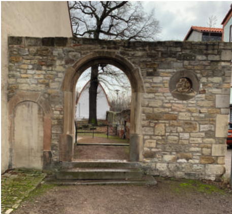
Vor der Renovierung
