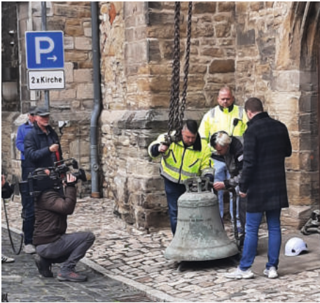
Vorbereitungsarbeiten Foto: Gottfried Weyhe
